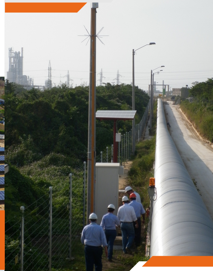
Cercos perimetrales ARGOS
